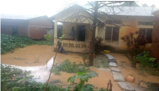
Das Wohnhaus des Priesters: früher ein Garten, jetzt überflutet
